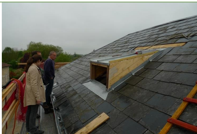
Aménagement d'une « chiroptière » lors de la rénovation d'une mairie© Maxime LEUCHTMANN
