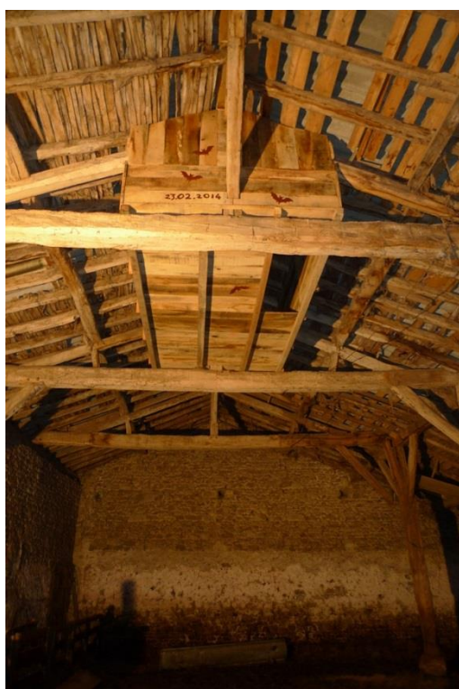
Aménagement d'un gîte « piège à chaleur » dans un élevage ovin © Maxime LEUCHTMANN
