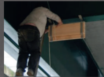
Installation de gîte artificiel sous un ouvrage d'art
