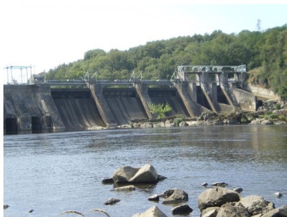
Les barrages hydroélectriques sont de véritables obstacles aux transports sédimentaires et à la libre circulation piscicole. (Photo : M. Gaillardrat – Vienne Nature)
